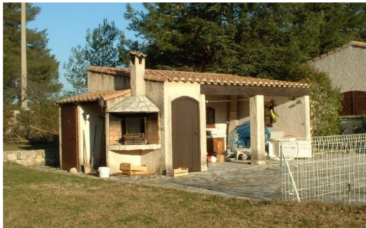
Figure 1. Vue du local piscine (avant travaux de rénovation)
