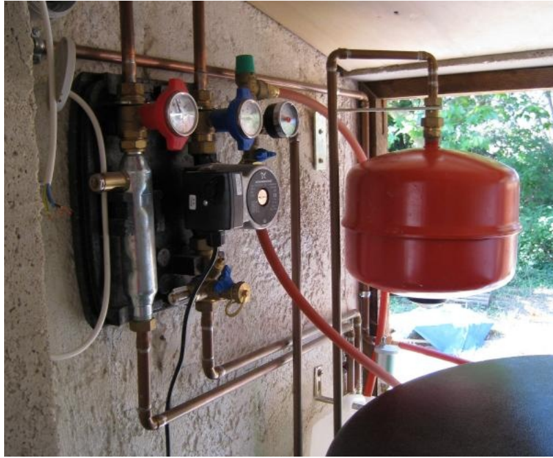
Figure 13. Le groupe hydraulique
