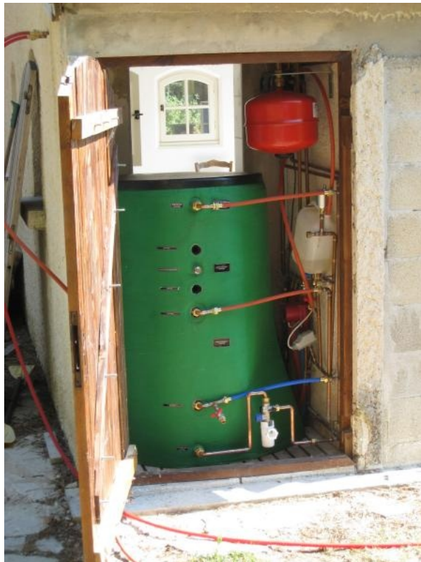
Figure 14. Le ballon installé dans son local technique
