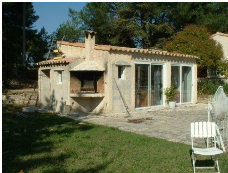
Figure 6. Vue du local pendant les travaux
