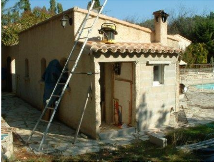
Figure 7. Accès aisé au toit
