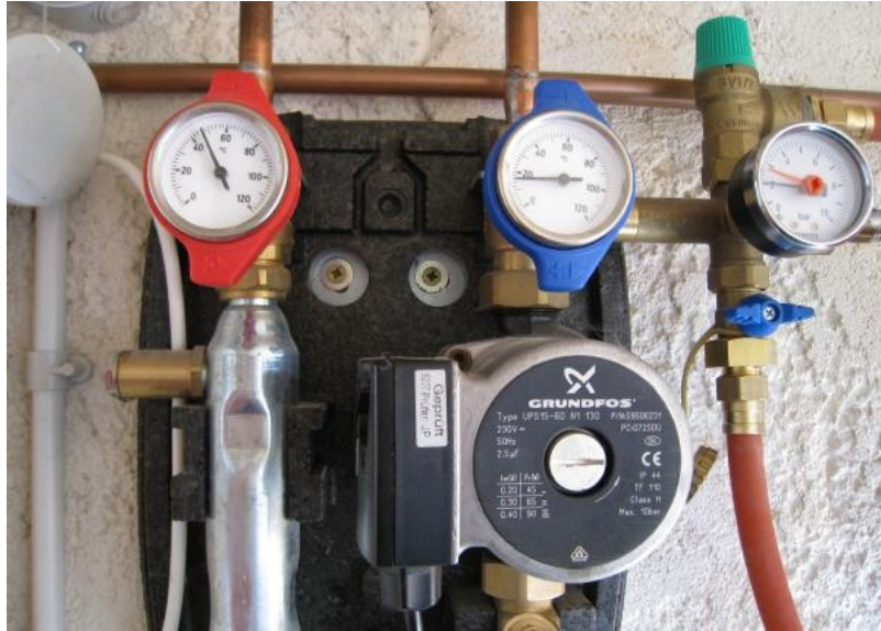
Figure 16. Température entrée et sortie du ballon (delta T 30°C)
