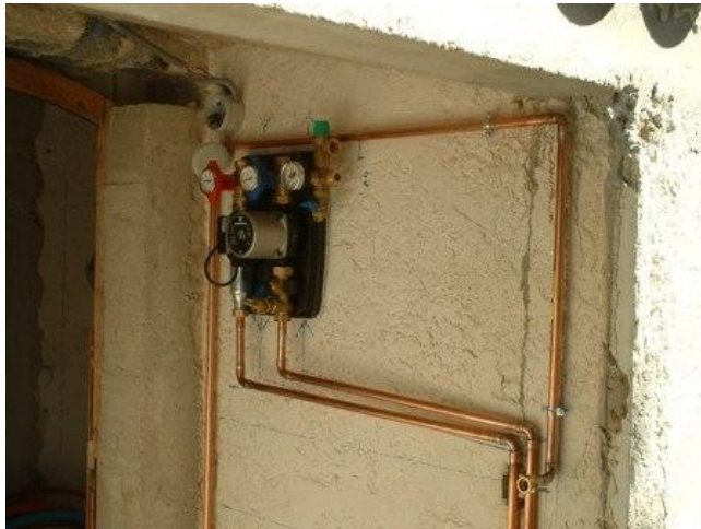
Figure 10. Le groupe hydraulique
