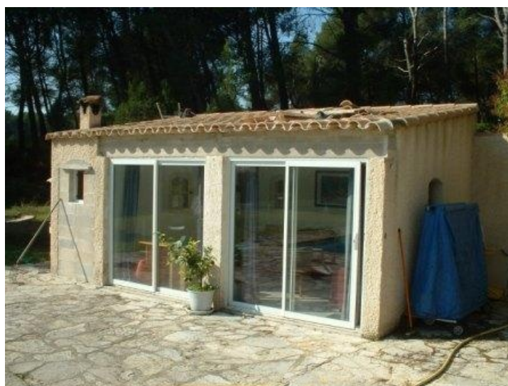
Figure 2. Vue du local piscine (en cours de travaux de rénovation)
