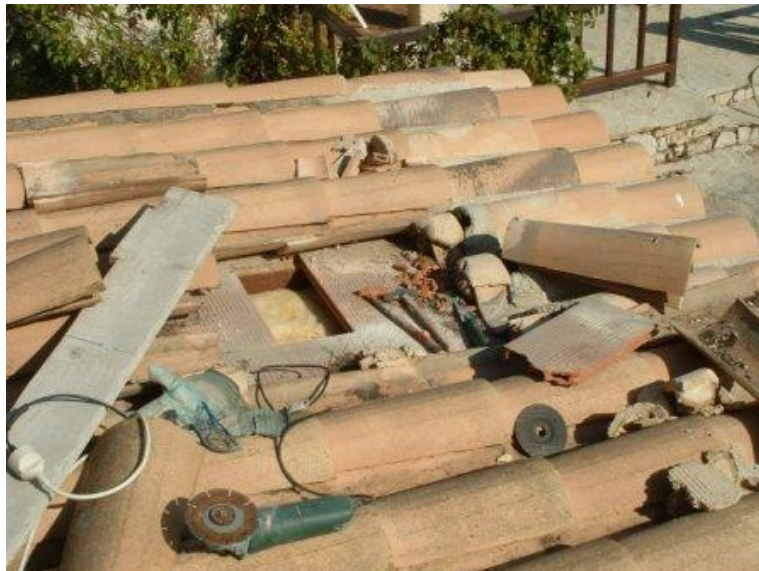
Figure 8. Recherche des points d'ancrage des supports de panneaux
